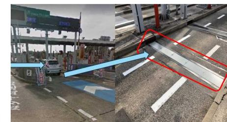
↑ 大高料金所での軸重、軸数同時計測機器設置状況
