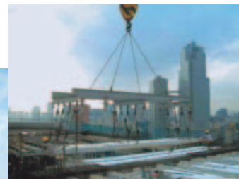
長大スパン床PCa板取付作業
