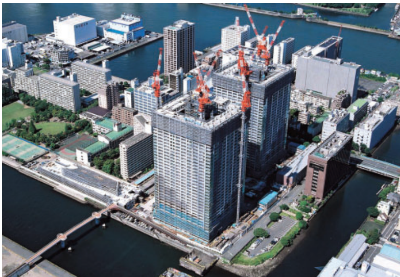
平成18年9月現在の施工状況
