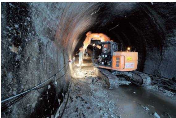
放水路トンネル施工の準備作業
