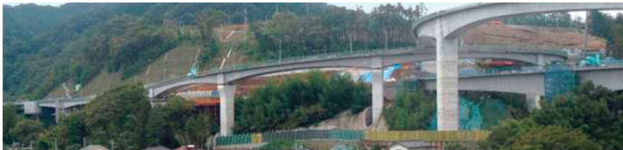
施工中工事写真（平成25年10月撮影）
