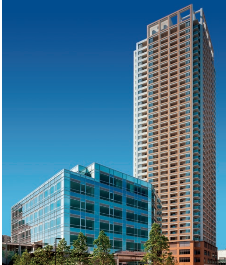
本八幡A地区第一種市街地再開発事業施設建築物等新築工事（第1期）
