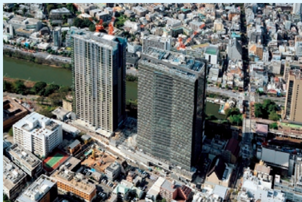
工事中の建物全景（平成25年10月撮影）
