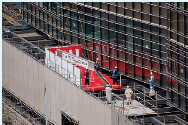
上棟式（上棟行事／上棟鉄骨揚重）
