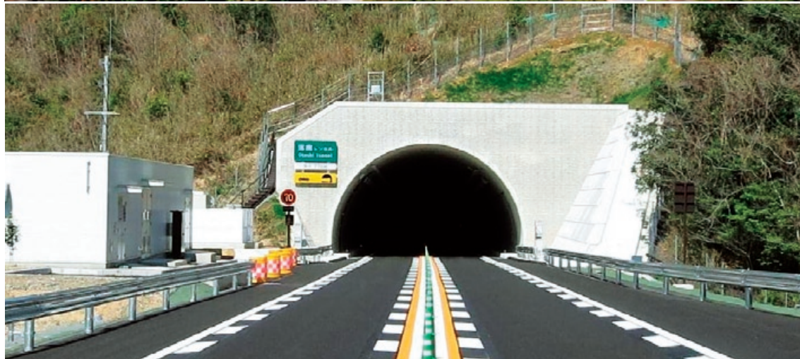
東九州自動車道 落鹿トンネル工事
