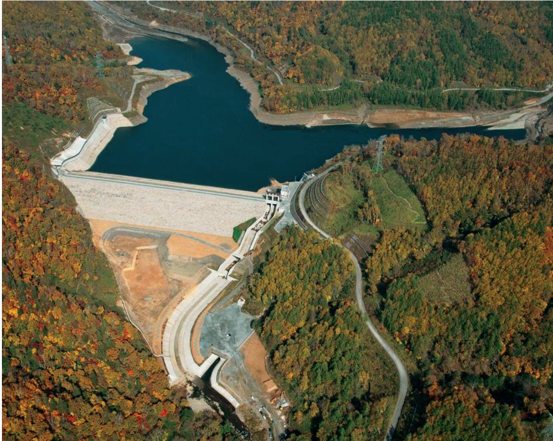
京極発電所新設工事のうち土木本工事（第4工区）
