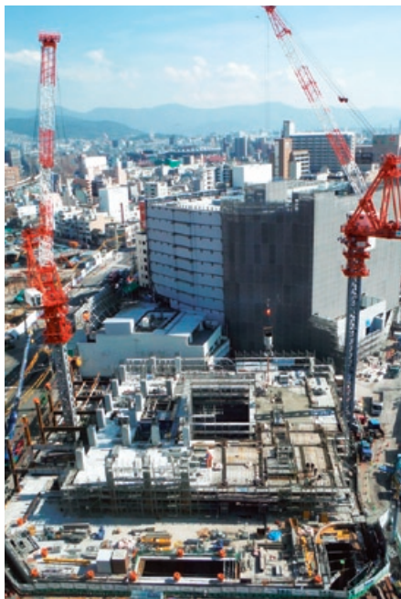
平成26年10月撮影 施工中工事写真（西面）
