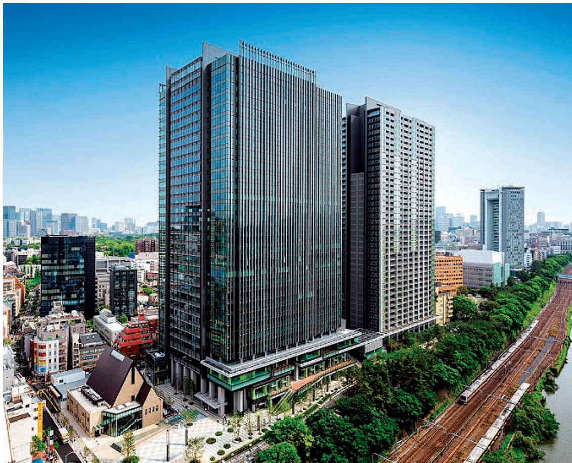
飯田橋駅西口地区第一種市街地再開発事業 業務・商業棟および住宅棟新築工事
