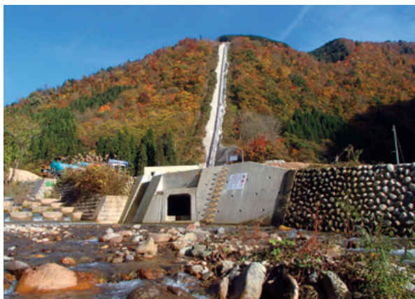
片貝別又発電所新設工事のうち土木本工事（富山県）
