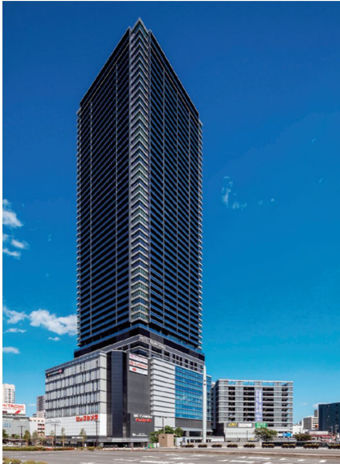
広島駅南口Bブロック第一種市街地再開発事業 施設建築物新築工事 (広島県)
