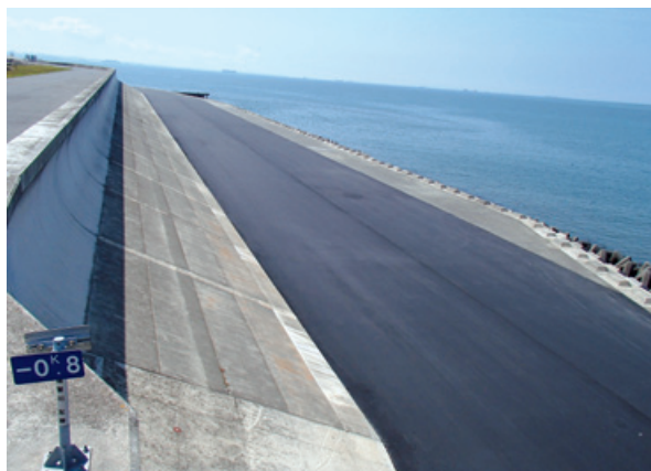
平成27年度 揖斐川長島浦安川表高潮堤防補強工事（三重県）
