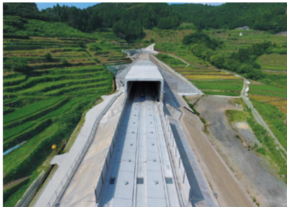
九州新幹線（西九州）、俵坂トンネル（西）他 （佐賀県）
