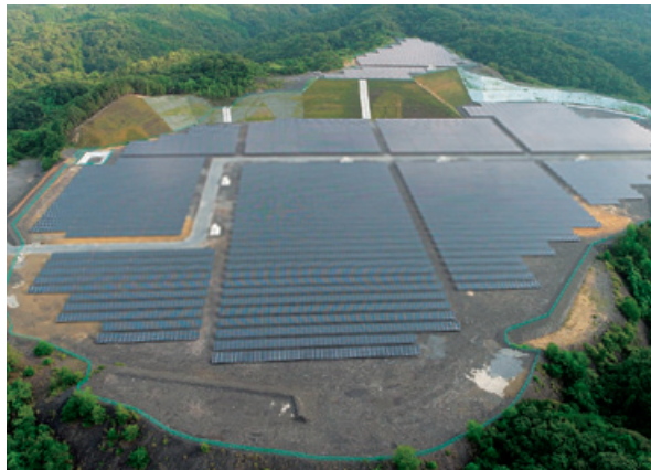
美祢太陽光発電事業建設工事（山口県）
