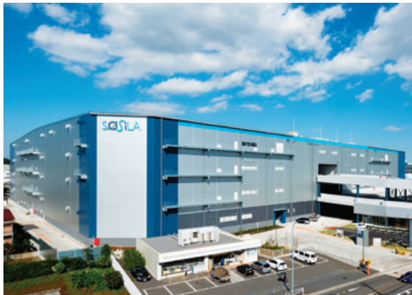
SOSILA横浜港北新築工事（神奈川県）
