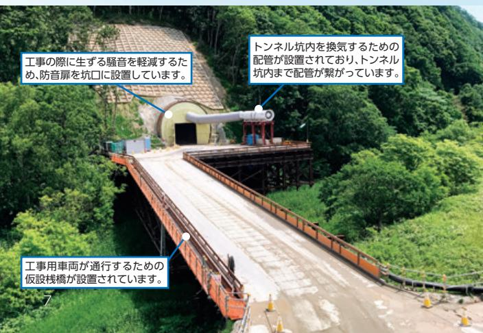
トンネル坑内を換気するための配管が設置されており、トンネル坑内まで配管が繋がっています。
