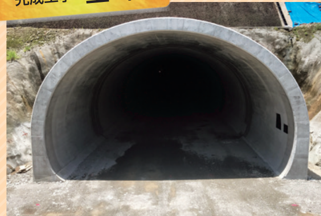
平成29年度 42号尾鷲第4トンネル南部工事
