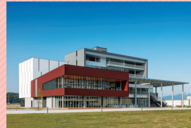
双葉町産業交流センター建築工事
