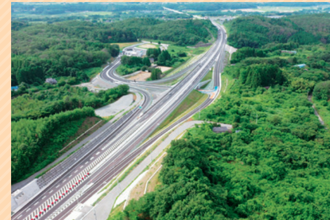
常磐自動車道 双葉インターチェンジ工事
