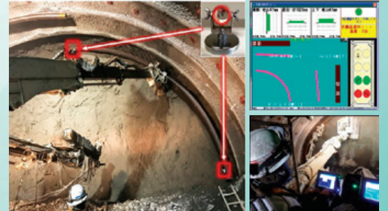
写真左 鋼製支保工へのプリズム設置と位置合わせ状況
