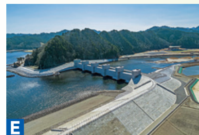
二級河川鶴住居川筋 鶴住居地区 河川災害復旧(23災647号) 水門土木工事
