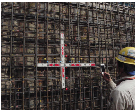
写真1 配筋写真撮影状況
