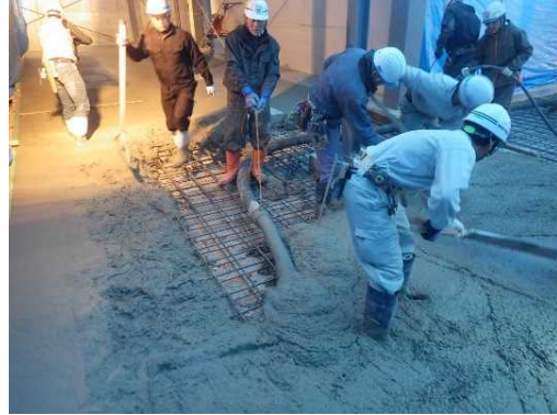
低炭素型のコンクリートの施工状況
