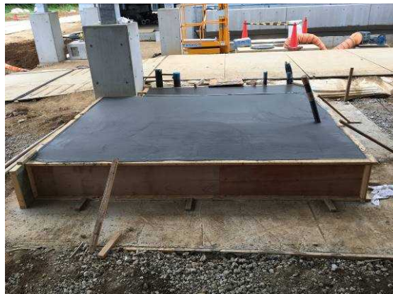
ジオポリマーの仕上げ完了後の状況
