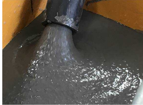
ジオポリマーの圧送状況
