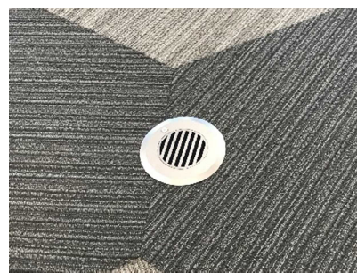
エクステンジ棟設置状況
