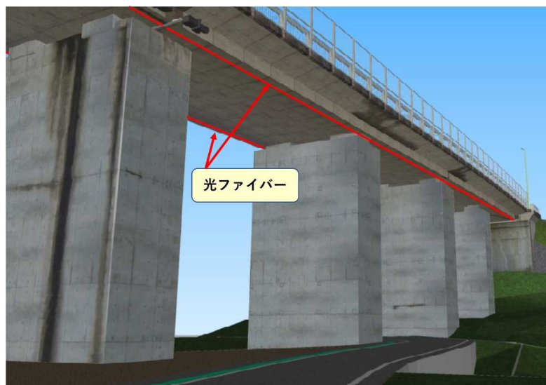
実橋梁下への光ファイバー取り付けイメージ
