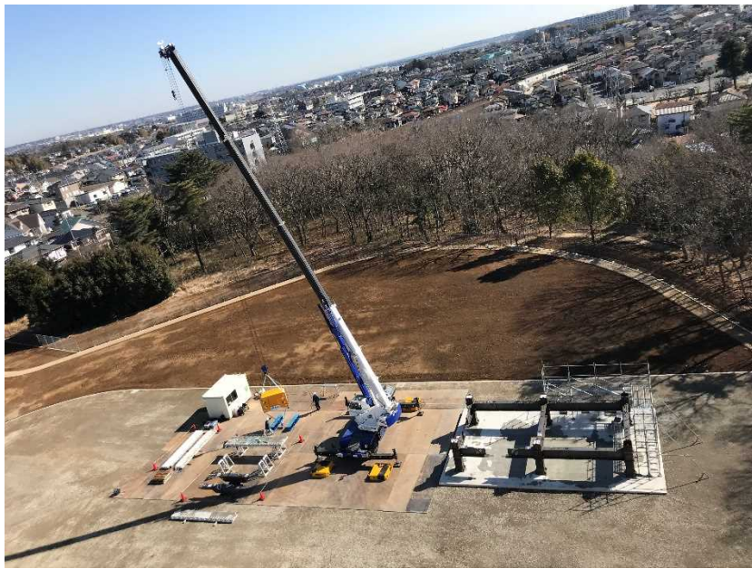
実証試験全景
