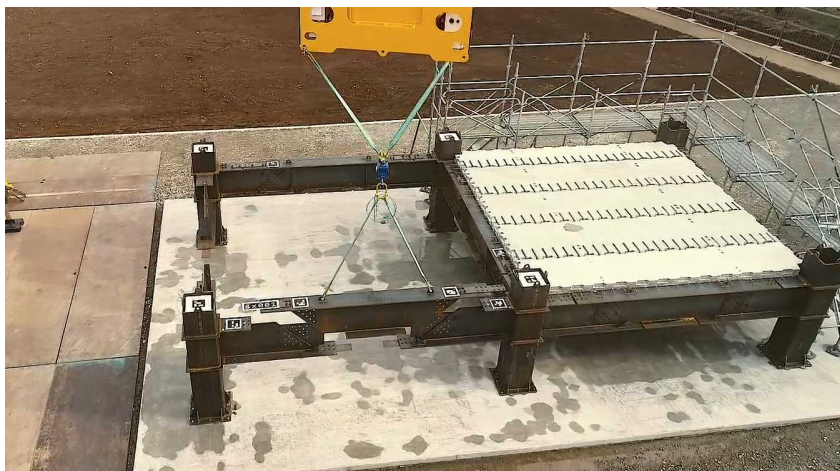
鉄骨梁の自動設置
