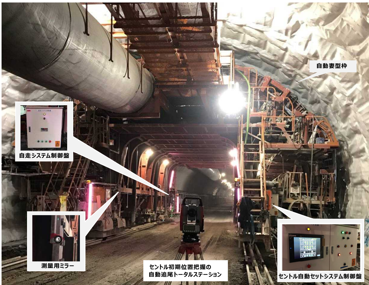
写真2 尾鷲第四トンネルにおける現場稼働状況
