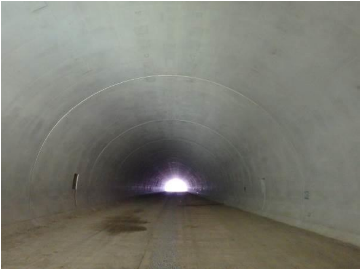
写真2: 高木トンネル覆工状況
