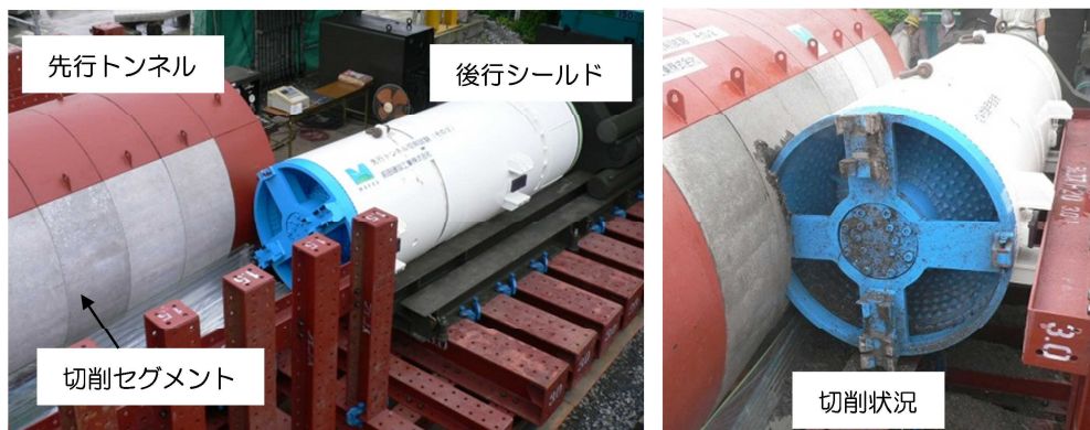
図-2 セグメント切削シールド工法の切削実証試験状況(2006年)
