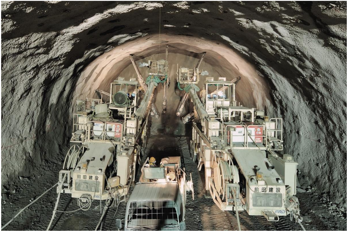
切羽施工状況
