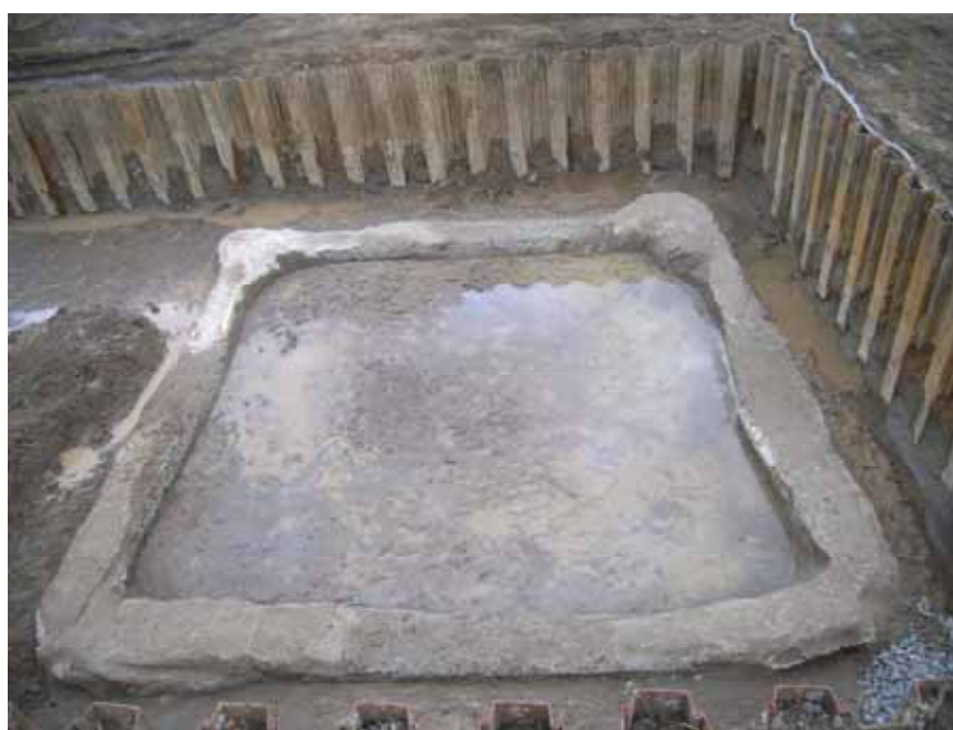
改良体掘起し状況(格子状改良)
