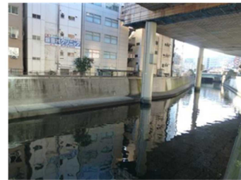
神田川右岸側 （飯田橋3丁目ビル予定地のある側）
