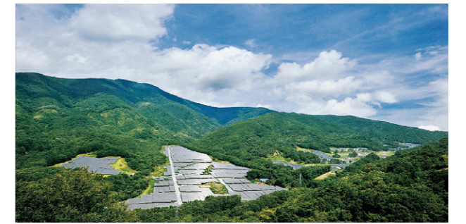
五葉山太陽光発電所 岩手県大船渡市五葉牧野。発電出力18MW、パネル総数73,440枚、供給能力は一般家庭約5,800世帯分に相当。
