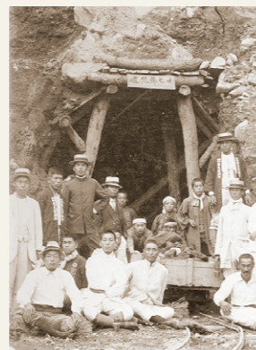
木曾福島第2水力発電所工事現場で。前列中央に座っているのが初代又兵衛
