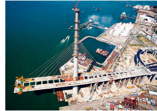
主塔の左右がアンバランスで、台風など風の影響を受けやすいため、側径間の橋桁を先につくり、中央径間に桁を張り出す工法を採用
