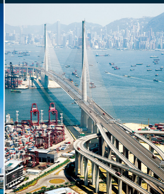
2009年竣工 ストーンカッターズ橋
