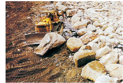
高瀬ダムの表面は、直径1m以上もある玉石を8万個、チルトドーザーで一つひとつ並べて仕上げられている
