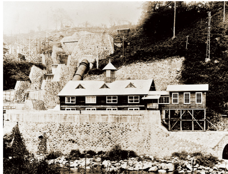
木曾福島第2水力発電所(長野)
