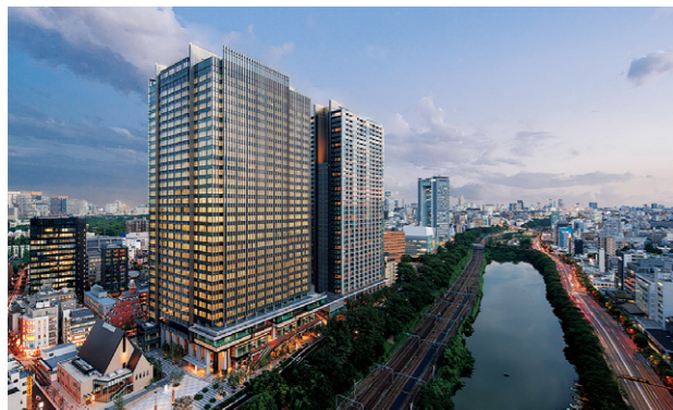
飯田橋駅西口地区再開発(東京)
