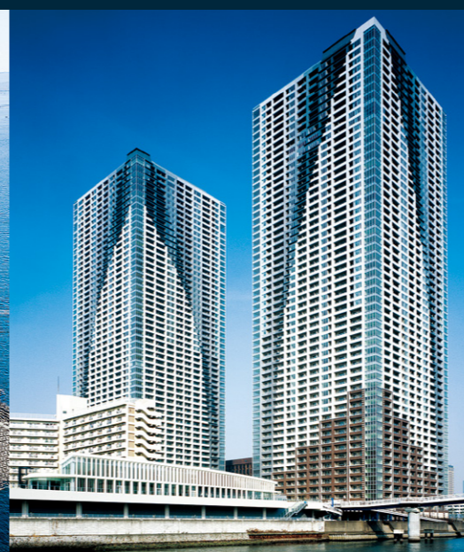
2008年竣工 THE TOKYO TOWERS
