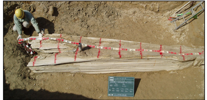
図-2 改良径確認状況(半径 R=4.5m)
