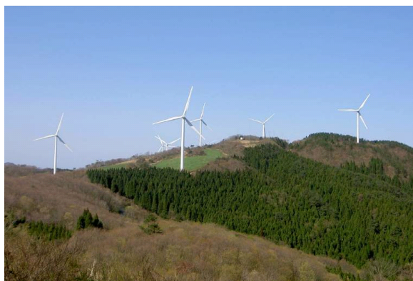
写真-1 計測対象風車の設置状況
