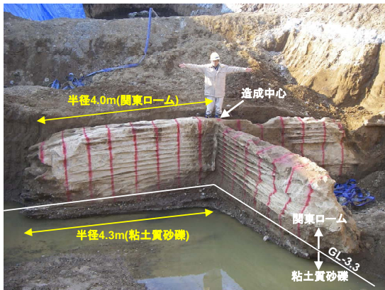
図-1 マルチジェット工法改良体
