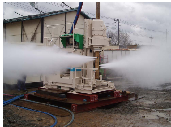
図-2 マルチジェット工法噴射状況
