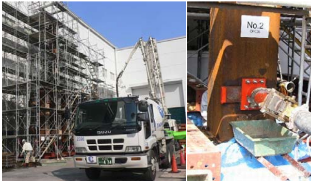
写真 実大施工実験状況
