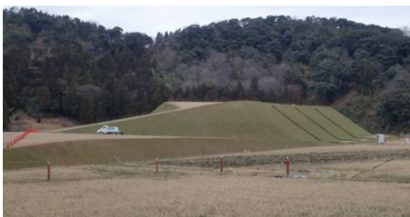
図-1 真空圧密工法を適用した载荷盛土
