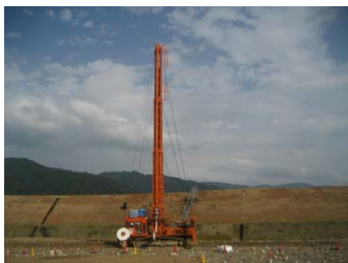
写真-1 PBDの施工状況
