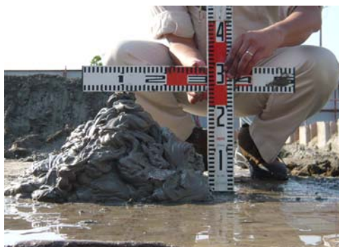
写真-1 端部隔壁工試験打設結果
