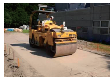
写真-2 転圧試験状況
