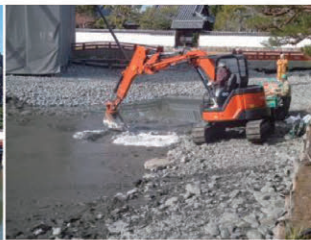
写真-2 底質安定化処理状況
