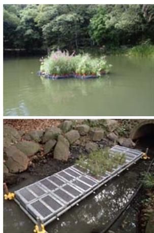
写真-1 (上)植生浮島, (下)礫間接触酸化槽
