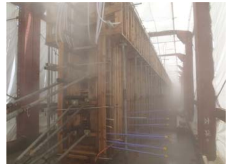
写真-1 ミスト養生の実施状況
