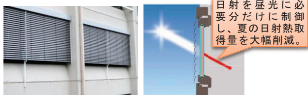
図-2 外付け電動ブラインドの外観、特徴
