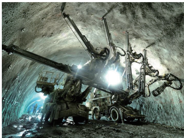
写真-1 ロックボルト 2 台施工状況
