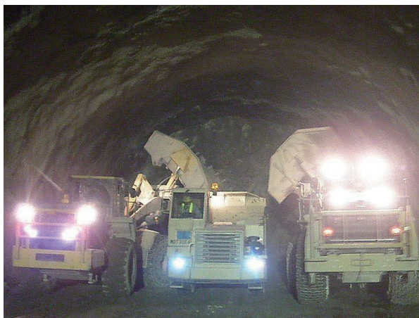
写真-2 すり出し 2 台施工状況
