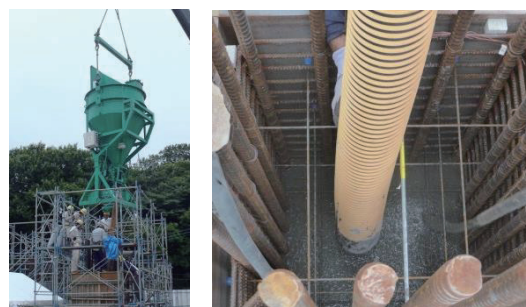
写真-2 実機実験時の柱部材試験体の打込み状況
