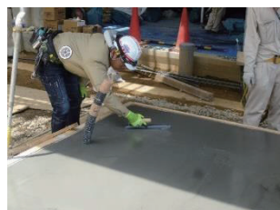
写真-1 ジオポリマー施工状況（左から、スランブフロー状況，打込み状況，押さえ状況，打込み完了状況）
