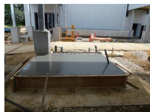
写真-1 ジオポリマー施工状況（左から、スランブフロー状況，打込み状況，押さえ状況，打込み完了状況）
