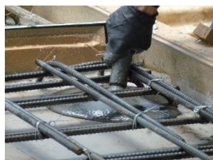
写真-1 ジオポリマー施工状況（左から、スランブフロー状況，打込み状況，押さえ状況，打込み完了状況）
