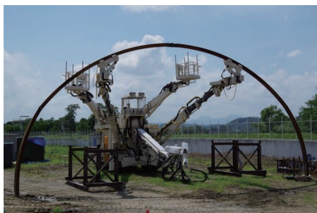
写真-1 鋼製支保工建込みロボット全景
