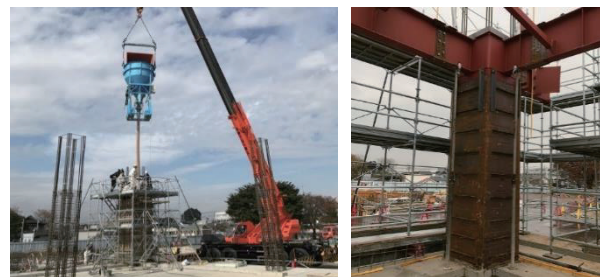
図-3 柱の施工状況
