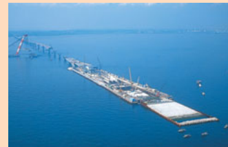
東京湾アクアライン (1998年完成) 世界最大径シールドによる自動掘進、セグメント自動 組立
