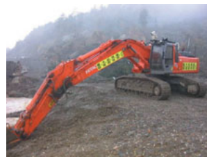
無人化施工機械による道路復旧
