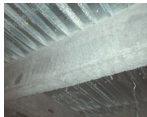
鉄骨梁の耐火被覆状況
