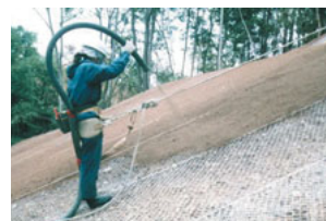
法面吹付状況
