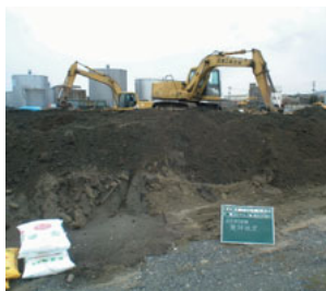
バイオ処理の施工状況
