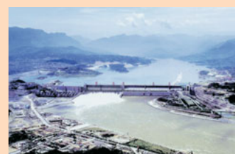
三峽ダム (2003年ダム本体完成) 海外 (中国) におけるCM業務 (コンストラクション・ マネジメント)
