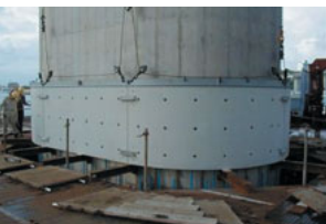
パネルをおろしている状況（泊大橋）
