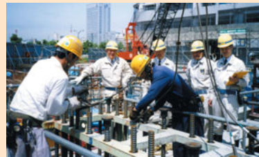
作業内容の巡視
