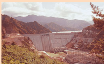
田子倉ダム (1960年完成) 東洋一 (当時) のコンクリート重力ダムを建設
