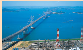
瀬戸大橋 (1988年完成) 本州と四国を結ぶ長大連絡橋
