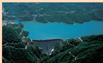
有峰ダム (1961年完成) 田子倉ダムと同規模のダムを自然と戦い同時期に建設
