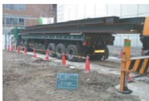
連続地中壁で使用した電炉鋼材
