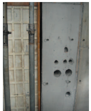
仕上がり状況
