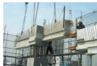
PCa建方状況
