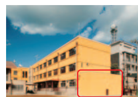
耐震補強部分
