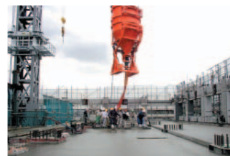
コンクリート打設状況
