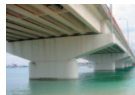
改修後の状況
