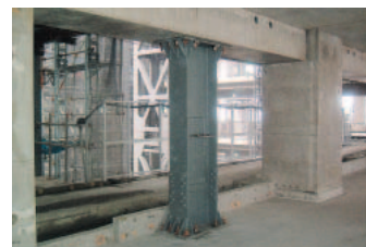
制振間柱設置状況
