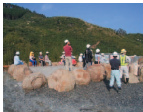
建設現場の見学会
