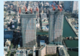
THE TOKYO TOWERS 国内最大級のマンション(建設中)
