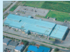
石川県金沢食肉流通センター BSE対応の国内最高レベルのHACCP工場 (2005年竣工)
