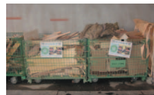
建設発生木材分別
