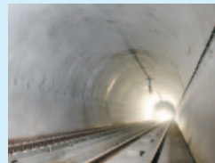
八甲田トンネル 世界最長の陸上トンネル(2005年貫通)
