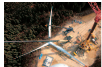
狭小地でのブレードの地組の状況
