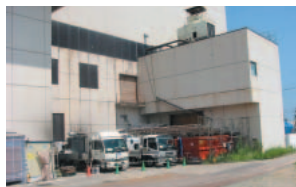
汚染水高度処理施設
