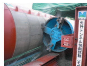
先行トンネル切削実証試験
