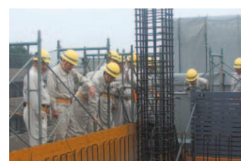
経営陣による現場巡視
