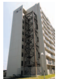
バットレス制振フレーム
