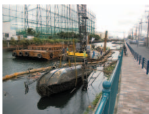
沈廃船除去作業の様子
