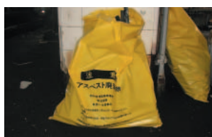
アスベストの廃棄物の袋詰め状況
