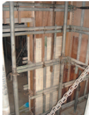
透明型枠使用
