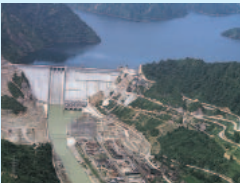
田子倉ダム(福島) 当時、東洋一規模の重力式コンクリートダム (1960年竣工)
