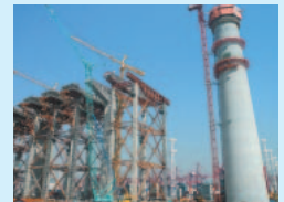
ストーンカッターズ橋(香港) 世界最大級の斜張橋(建設中)
