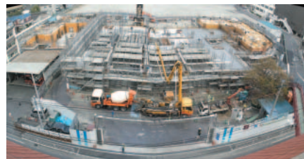
工事現場全景
