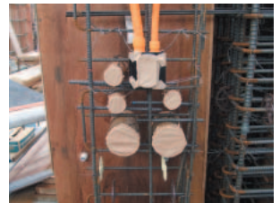
スリーブの配置状況（従来の型枠）
