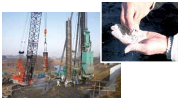
高含水比の残土が出る現場の状況とペーパースラッジ(右上)
