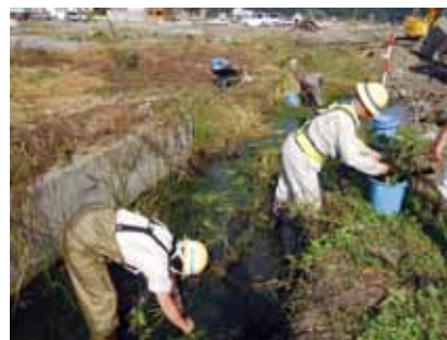
「ミズアオイ」の移植作業の状況
