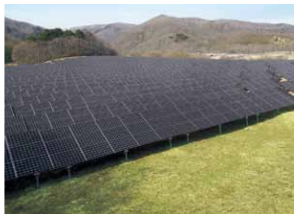
五葉山太陽光発電所の建設状況(東北支店五葉山メガソーラー作業所)
