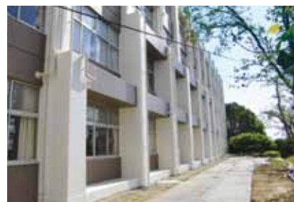
MaSTER FRAME構法による補強（三田松聖学園）
