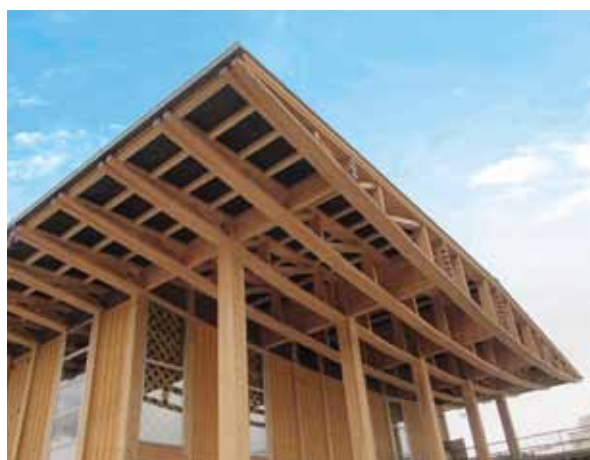
国産木材利用の状況(東北支店住田町新庁舎作業所)
