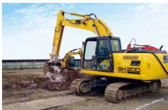
マグネシウム系固化材を使用したフッ素汚染土壌の不溶化封じ込め工法
