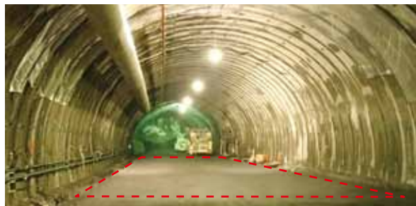
脱水ケーキのインパート埋戻し材への再利用 (九州支店山口第一トンネル作業所)
