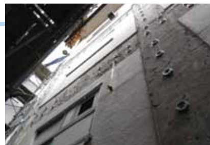
専用あと施工アンカー（ディスクアンカー）
