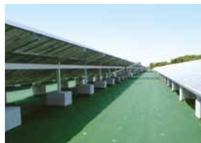
太陽光発電所の防草シート(つくば太陽光発電施設)
