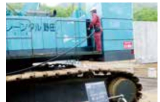
クローラークレーンへのBDF利用 (中部支店 防衛日野作業所)
