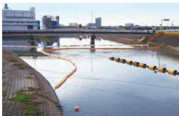
シルトフェンスの二重設置
