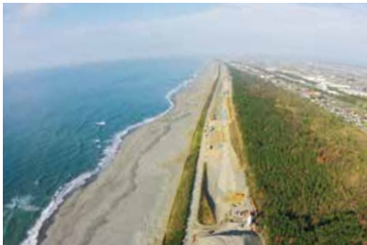
防潮堤工事状況
