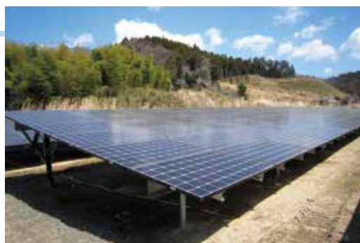
太陽光関連製品(北茨城メガソーラー作業所)
