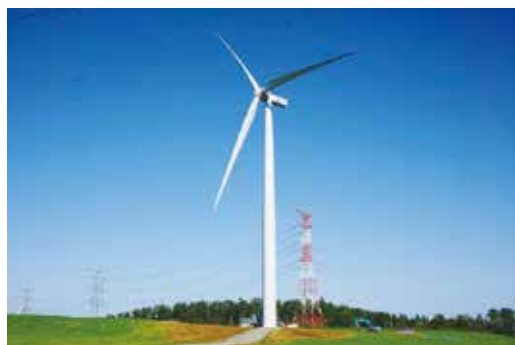
風力発電機近景
