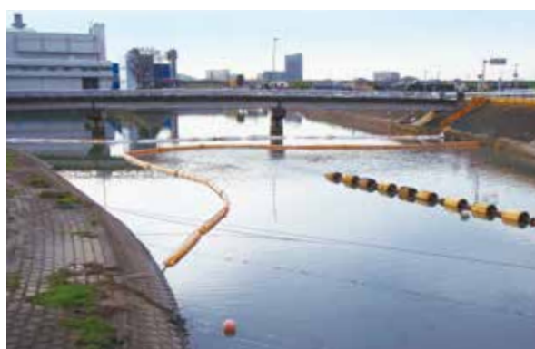
シルトフェンスの二重設置
