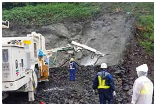
吹付試験施工
