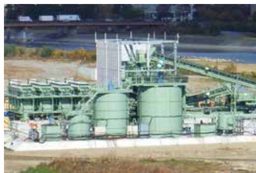
油汚染土壌対策工事(土壌洗浄)
