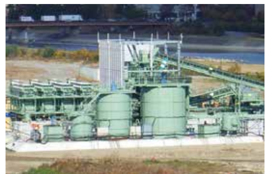
油汚染土壌対策工事(土壌洗浄)
