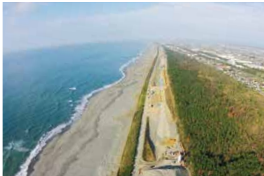
防潮堤工事状況
