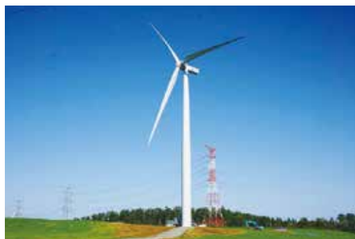
風力発電機近景
