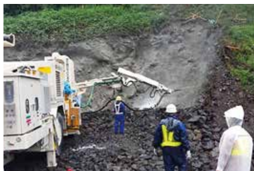
吹付試験施工
